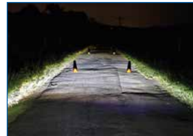
30 cm hoch: Der 40-m-Pylon ist noch sichtbar, darüber hinaus bleibt es dunkel.
